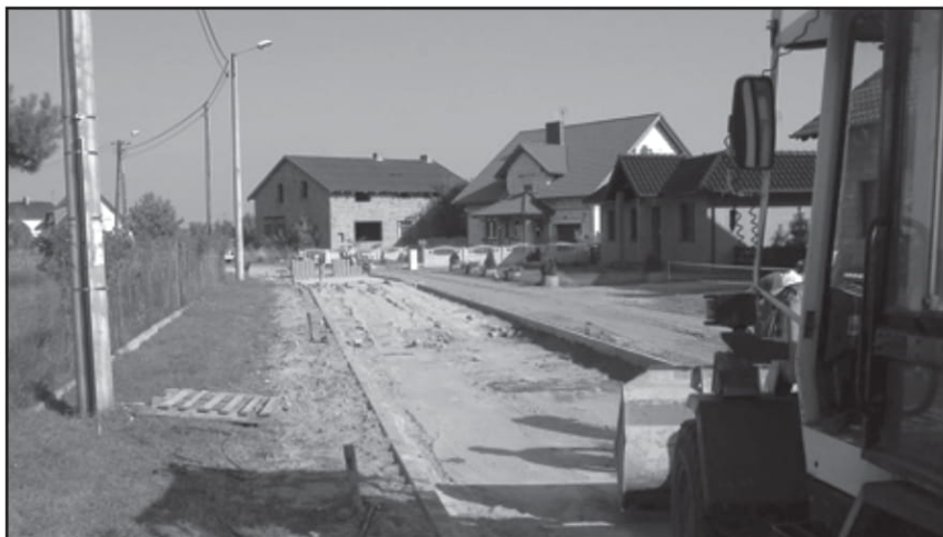
Przebudowa dróg gminnych w ubiegłym roku kosztowała łącznie 768.605,05 zł. Na zdj. budowa drogi z kostki brukowej na Osiedlu 700-lecia w Krzyczku Wielkim
